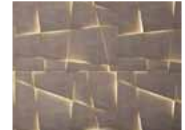
Mur de l'escalier en pierre Fossena, coupe géométrique et éclairage led Wall stairs stone Fossena geometrically cut with led
